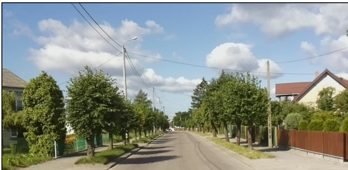
Fotografia 6. Zdjęcie drogi powiatowej w miejscowości Brańsk (ul. Bielska).
