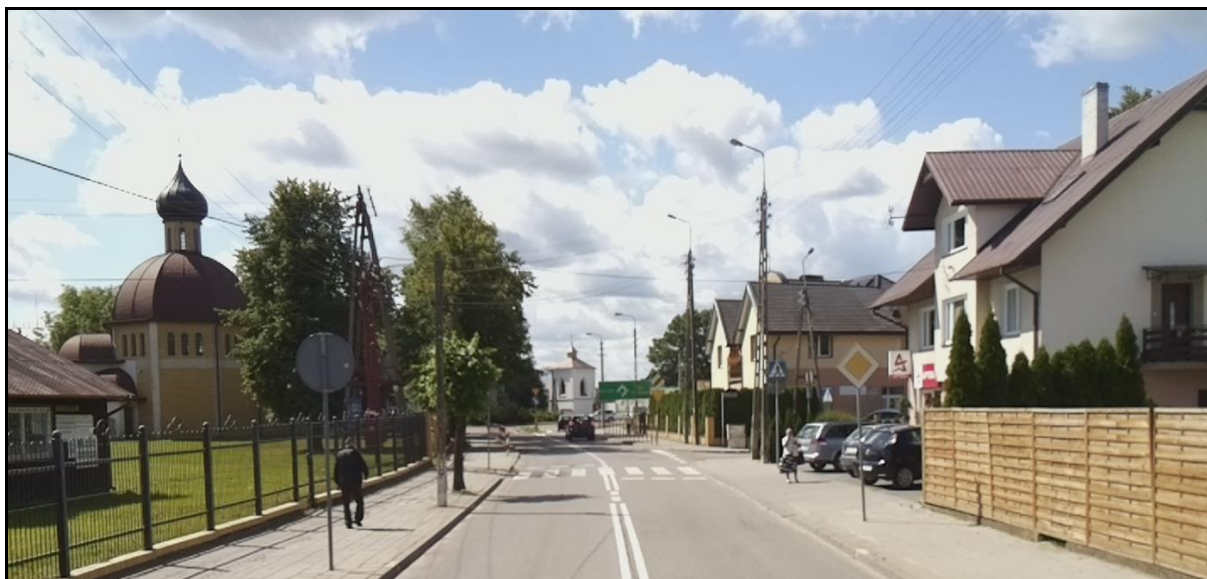
Fotografia 4. Zdjęcie drogi wojewódzkiej w miejscowości Brańsk (ul. Tadeusza Kościuszki).
