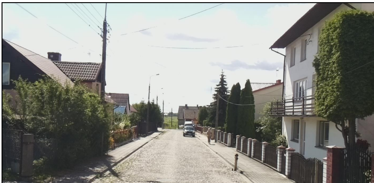
Fotografia 7. Zdjęcie drogi gminnej w miejscowości Brańsk (ul. Milewskiego).
